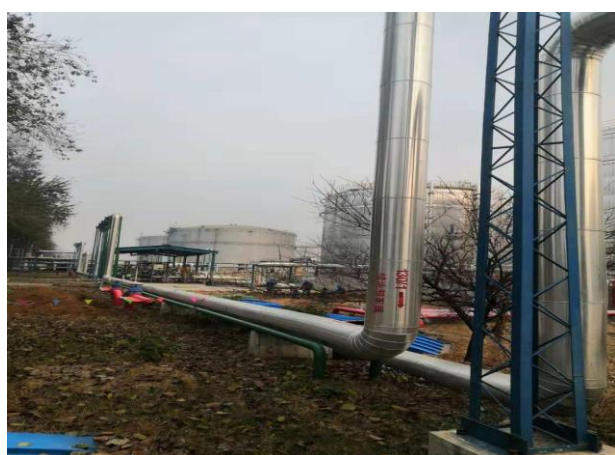
图 2-6 新增沥青装车输送管道
