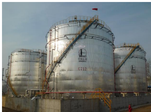
图 2-3 罐区盘梯平台
