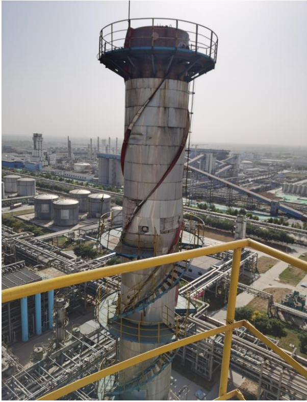
附图 2-2 原有脱硫脱硝塔
