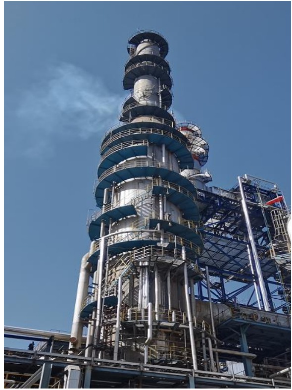
附图 2-2 原有脱硫脱硝塔
