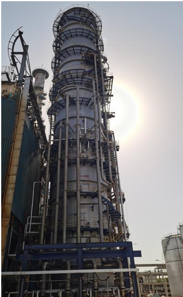
附图 2-3 新建脱硫脱硝塔
