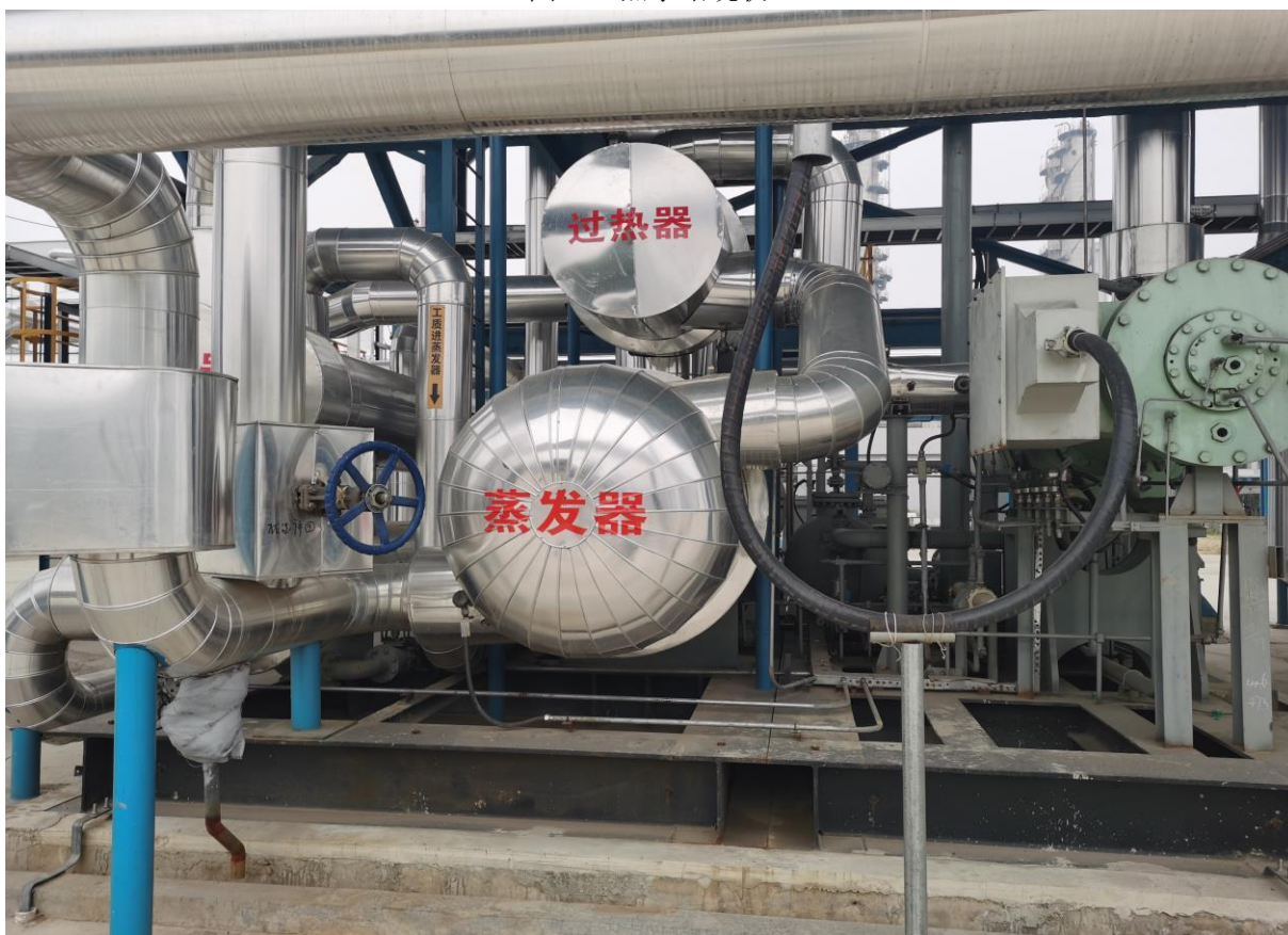
图 2-2 新增 ORC 发电机组
