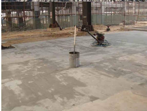
图 4.2-3 重点污染防治区地面刷防渗材料
