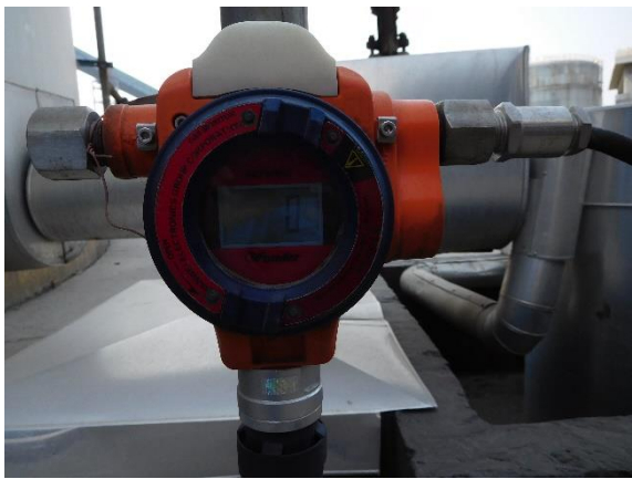
图 4.2-10 硫化氢气体报警仪
