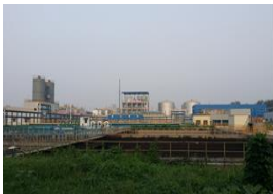
污水处理场全景
