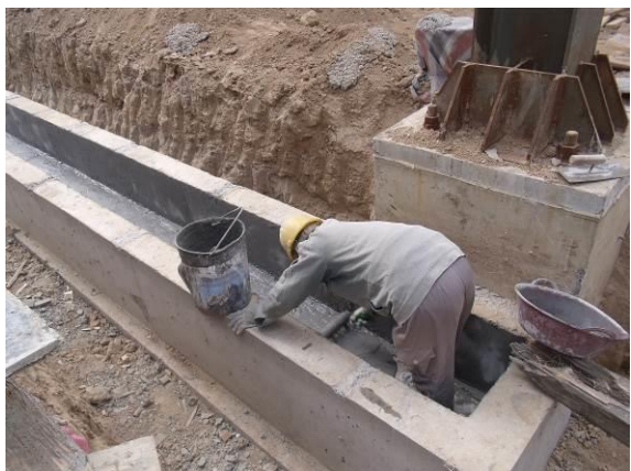
图 4.2-3 重点污染防治区地面刷防渗材料
