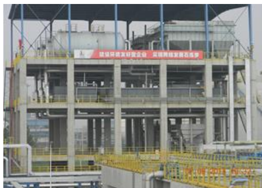
含油含盐污水处理系统预处理框架
