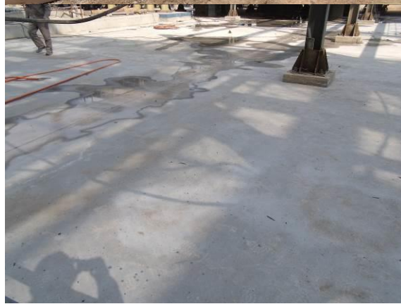
图 4.2-3 重点污染防治区地面刷防渗材料
