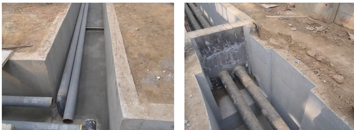
图 4.2-4 地下管沟内壁刷防渗材料
