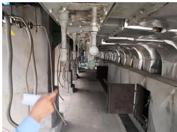
图 3.1-7 延迟焦化装置燃料进口断开
