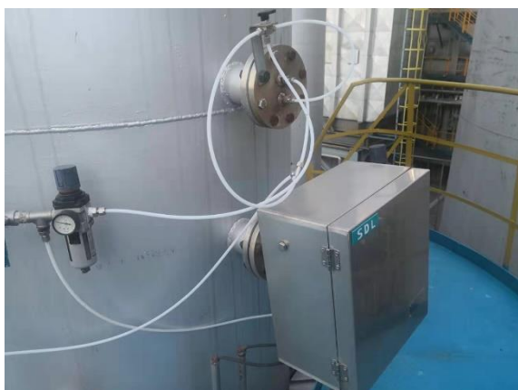
图 4.2-2 在线监测取样口
