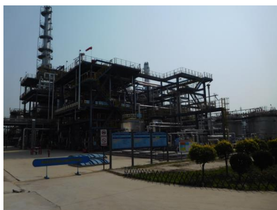
图 3.1-3 原 4.5 万吨年聚丙烯装置已拆除, 原址已另立项新建烷基化装置
