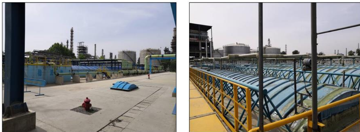
图 4.1-12 氧化沟及一体化生化反应池封闭情况
