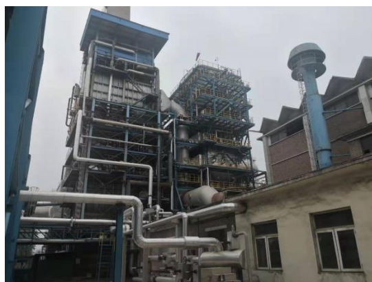
脱硝设施 (90 万吨/年催化)
