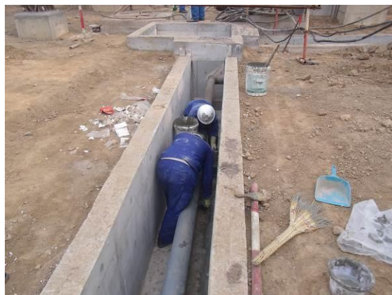
图 4.2-3 重点污染防治区地面刷防渗材料
