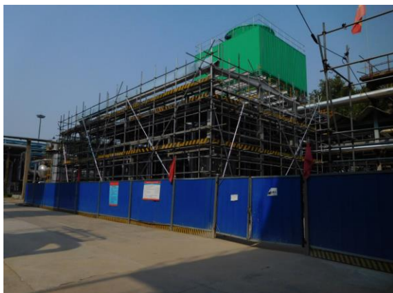
图 3.1-4 原 9 万吨年气分装置已拆除, 原地用于放置 350 万吨常减压新增溴化锂机组
