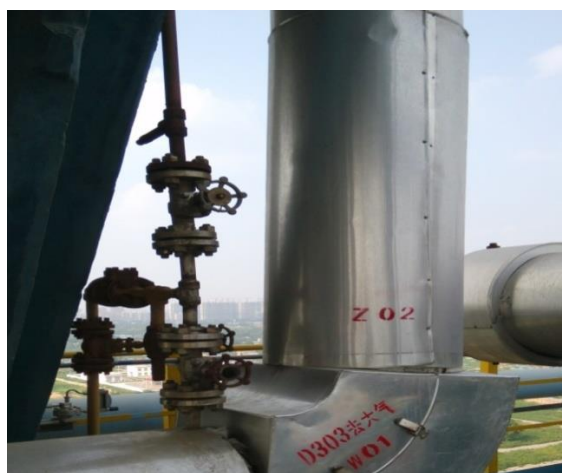
重整装置催化剂再生烟气采样口
