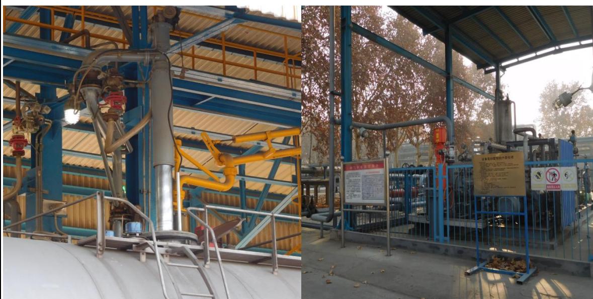
图3.6 汽车装车油气收集及增压设施
