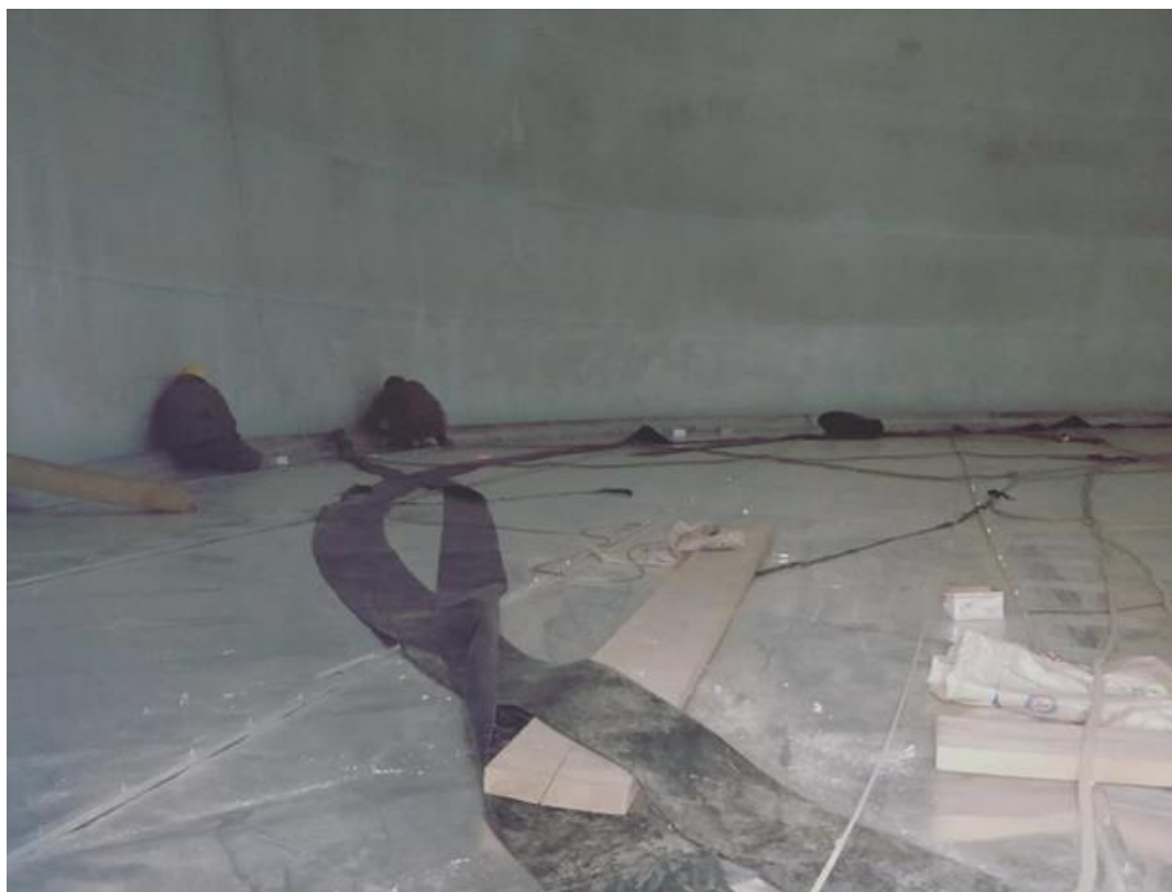
图 3. 13 5#罐区内浮顶改造现场施工图
