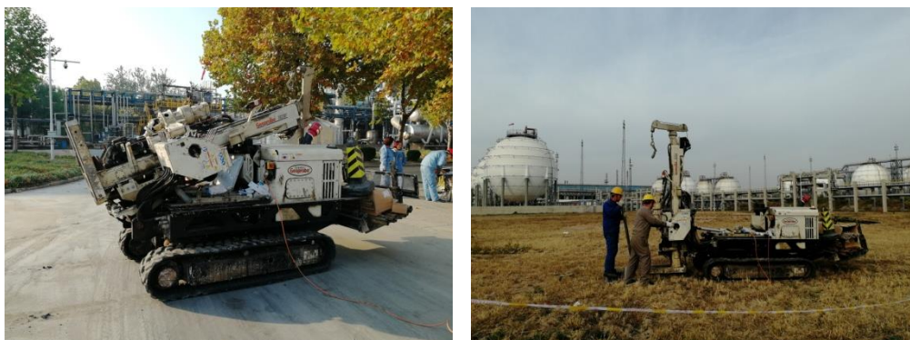
图 5 现场钻探用 Geoprobe 钻机及操作
