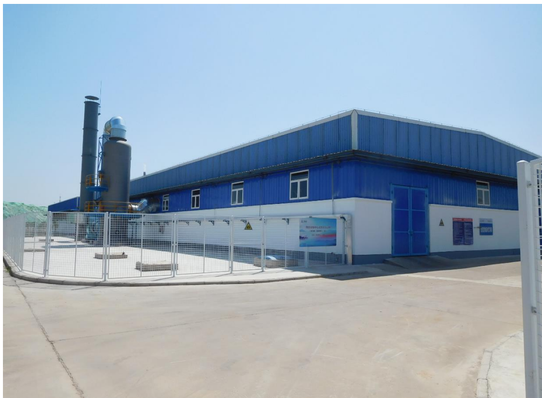
图 3-9 1 号危废暂存库全密闭
