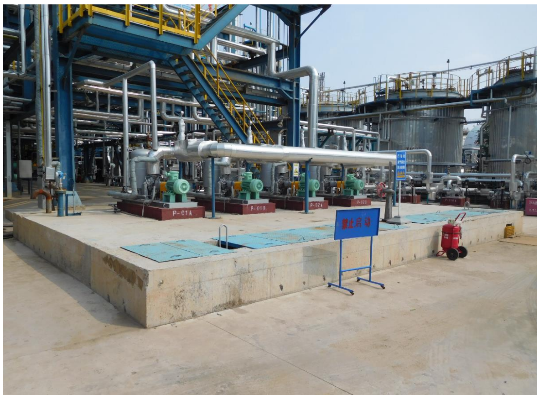
图 3-3 烷基化装置含油污水池
