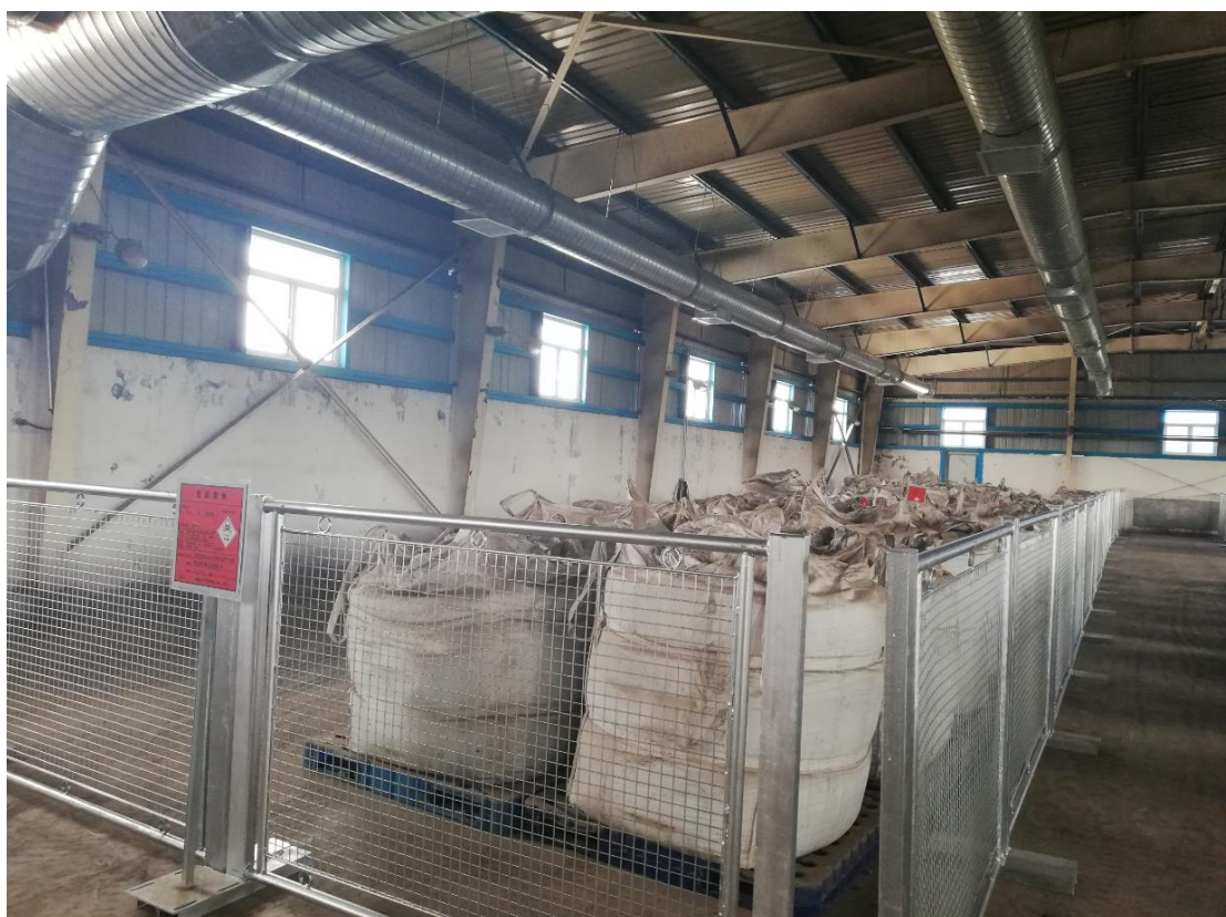
图 3-10 1 号危废暂存库内部情况
