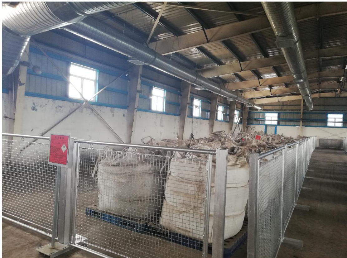
图 7.2 1 号危废临时贮存库情况
