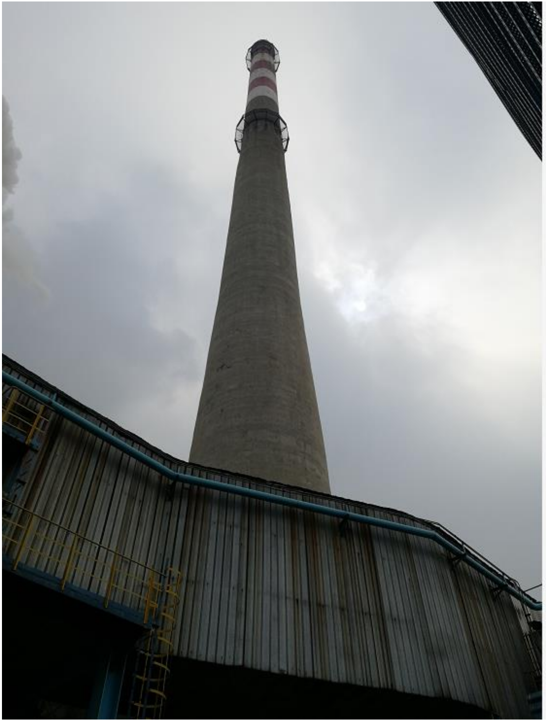
图 3.3 3#燃气锅炉烟气排放口
