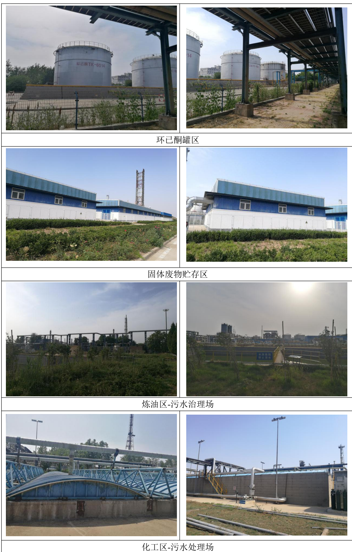
图 5.2-1 现场踏勘照片
