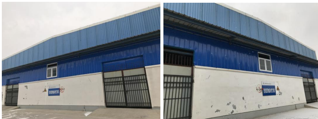
图 3-3 危废临时储存库
